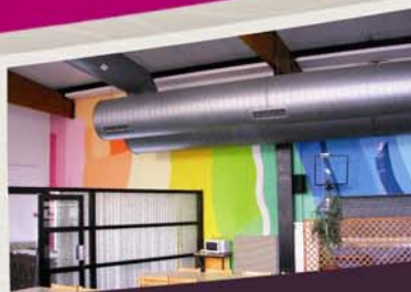
Colombes (92) Réfectoire Lycée Garamont
